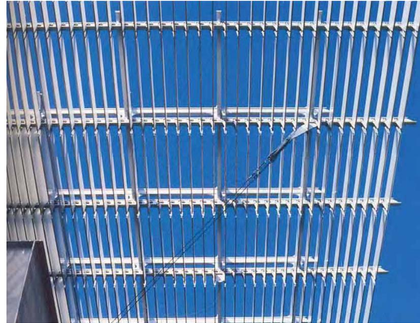
Parte del detalle de la techumbre reticular donde se aprecia un cambio en su contenido formal: en lo que corresponde al voladizo para generar una mascarilla de sombra sobre el cuerpo de exhibición y generar un confort térmico al controlar la incidencia de radiación solar, sobre un material como el metal y en los módulos que coinciden sobre la cubierta propiamente de la galería se observa una placa que genera opacidad entre el paralelismo de los perfiles metálicos.
