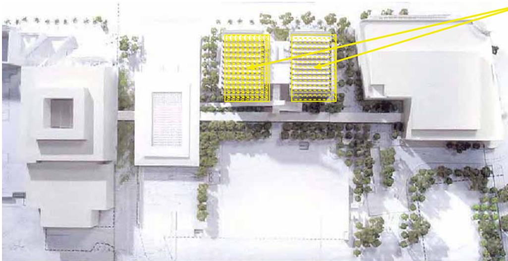
Áreas de exhibición con parasoles a manera de cubierta que condicionan la filtración de la luz solar y el aprovechamiento de la misma para iluminación y confort térmico
