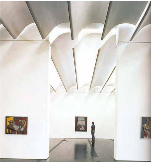
Vista de las hojas alabeadas paralelas de concreto que conforman la techumbre y controlan a manera de estrategia pasiva la filtración de luz solar al interior, sin permitir el contacto de la radiación sobre las obras expuestas.
