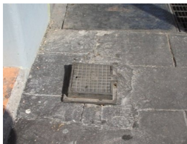
Fig. 1.12 Coladera arriba del nivel de la banqueta (Rep. Uruguay)
