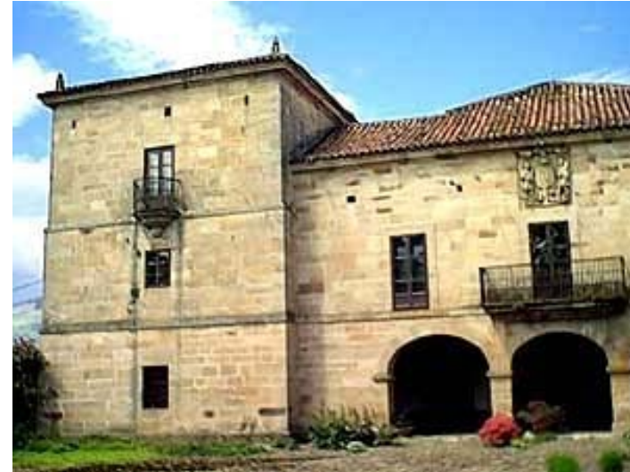
El emigrante suele reproducir en tierra extraña las marcas de su identidad, como un dispositivo cultural que refuerza la memoria del origen. En los masivos muros de un palacio en la población de Saro, se observa el mismo carácter robusto de los muros del Camarín. En «http://www.cantabriajoven.com/saro/index.html» .
