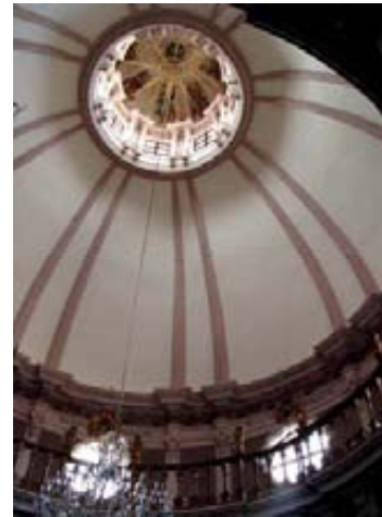
Vista interior de la cúpula y del capulín de la linternilla del Camarín de la Virgen, con su sistema de ocho “costillas” o “nervios” que conducen a un centro, “á donde tiran todas las lineas, y clave en que todos los arcos finalizan”, que es la Asunción Gloriosa de María. Templo de San Diego, Aguascalientes. Foto: MASS.
