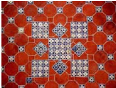
Detalle del diseño original del piso del Camarín, recientemente descubierto y restaurado. Foto: MASS.
