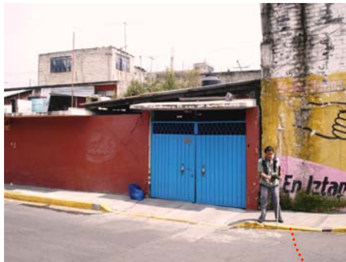
Fig. 2.20 Grieta Calle Agapando
