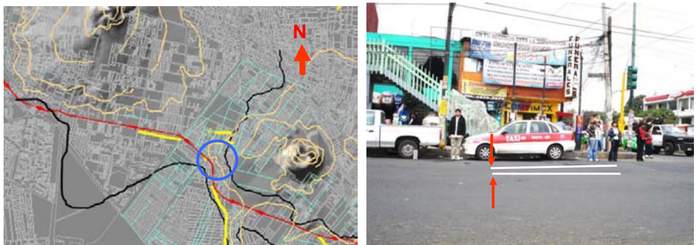
Fig. 2.9 Grieta Avenida de las Torres esquina Avenida Tlahuac
