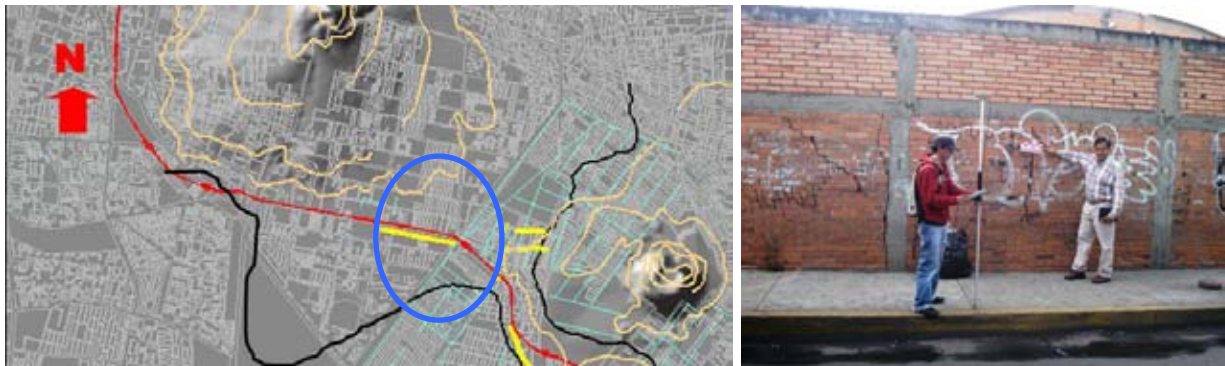
Fig. 2.7 Grieta Avenida 11 esquina Avenida Tlahuac
