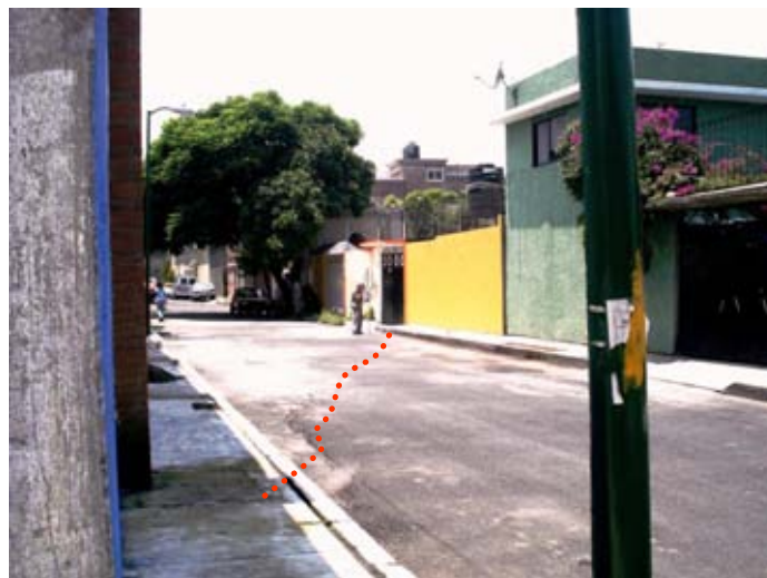
Fig. 2.21 Grieta Calle San Lorenzo esquina Calle Marisol
