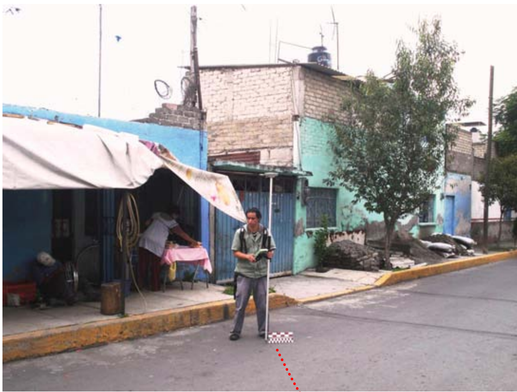
Fig. 2.26 Grieta Calle Cenicienta
