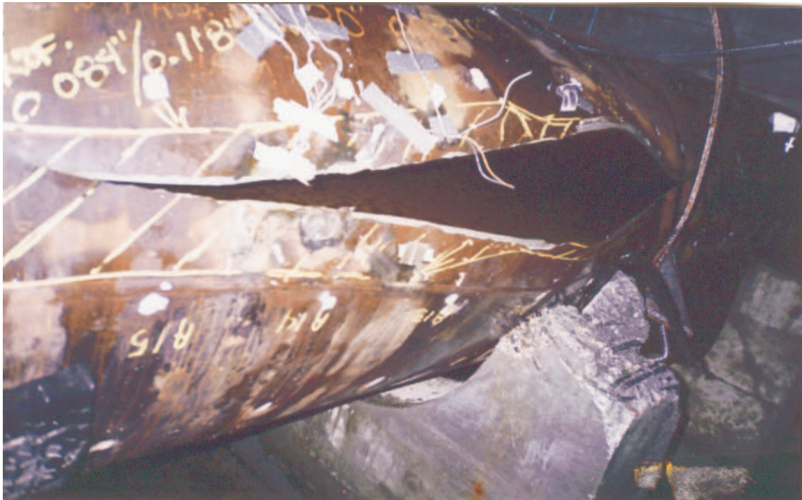
Figura 3.1. Falla por colapso plástico en la zona laminada, del tramo de tubería del tercer ensayo hidrostático.
