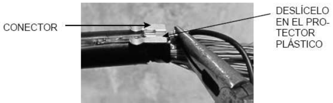
Figura 6.5. Instalación del conector.
