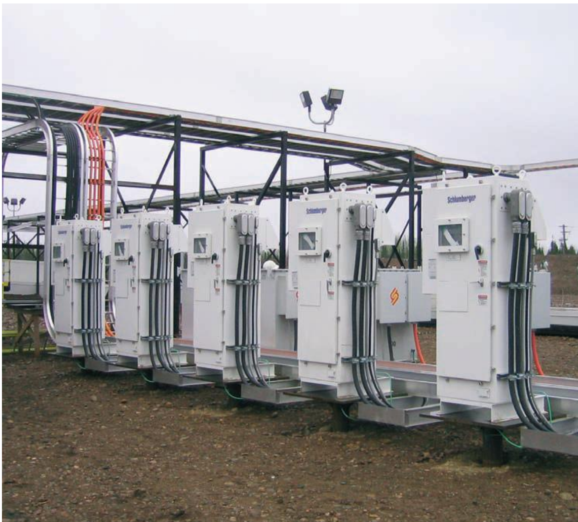
Fig. 1.6 Variadores de velocidad (VSD). Utilizando la electricidad generada por la empresa de electricidad local o en estaciones generadoras dedicadas, el VSD transmite la energía eléctrica dentro del pozo hasta el sistema ESP. El VSD es clave para controlar el desempeño de la bomba en forma remota. 17
