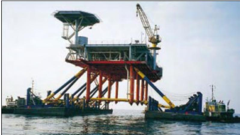
Figura 5.6-3 El sistema Versatruss elimina la necesidad de grandes grúas y barcasas. (Tomado de Oilfield Review, Schlumberger<sup>30</sup>, 2007).
