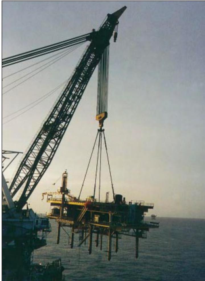
Figura 5.6-2 Una grúa gigante levanta la cubierta de una plataforma previamente derrumbada que servirá de arrecife artificial en el Golfo de México (Tomado de Oilfield Review, Schlumberger<sup>30</sup>, 2007).
