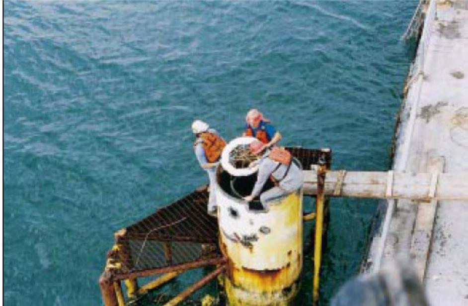
Figura 5.6-5 Especialistas en explosivos instalando el dispositivo en uno de los pilares de una plataforma en el Golfo de México (Tomado de Oil & Gas Journal<sup>46</sup>, 1997).
