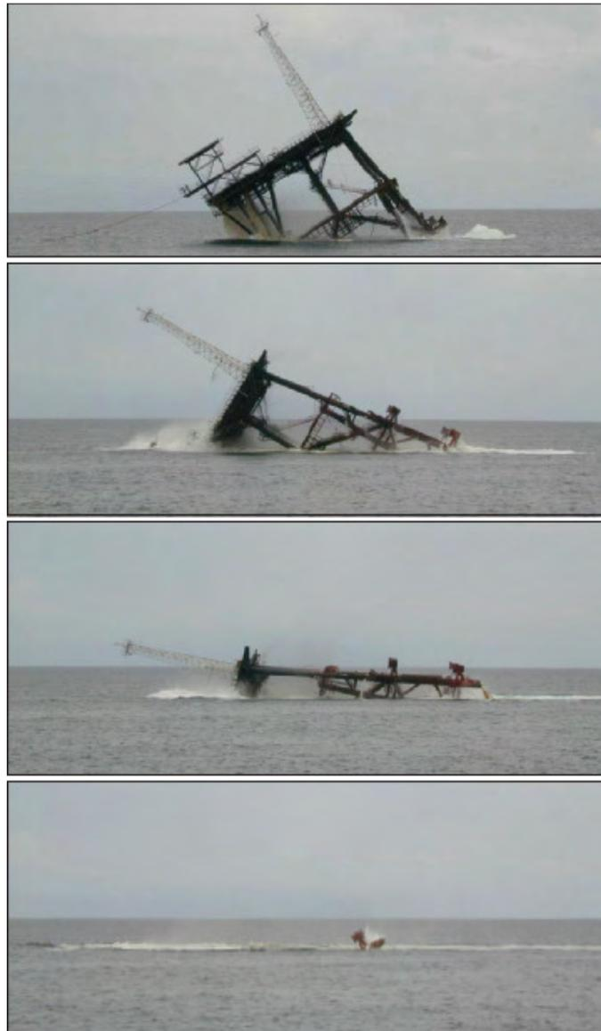
Figura 5.6-6 Hundimiento de una plataforma en el Golfo de México para ser usada como arrecife artificial. (Tomado de Oilfield Review, Schlumberger<sup>30</sup>, 2007).
