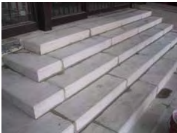
Fotos en las que se aprecia el nuevo junteo y se aplicó impermeabilizante silicón como protector.
