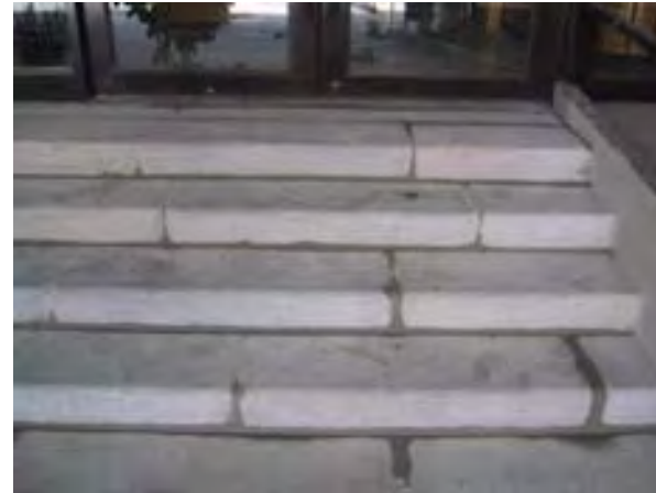
Fotos en las que se aprecia el nuevo junteo y se aplicó impermeabilizante silicón como protector.
