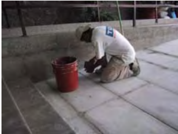
Fotos en las que se aprecia el nuevo junteo y se aplicó impermeabilizante silicón como protector.
