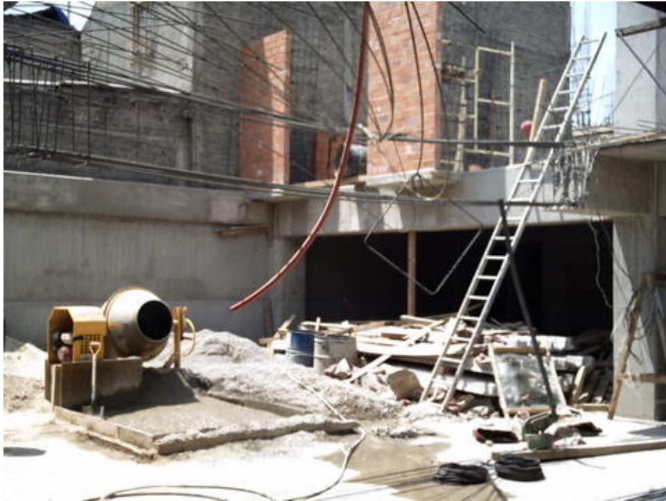
CONSTRUCCIÓN DE LA ESTRUCTURA
