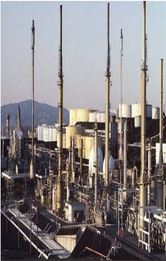
Refinería de petróleo Lawrence Migadle
