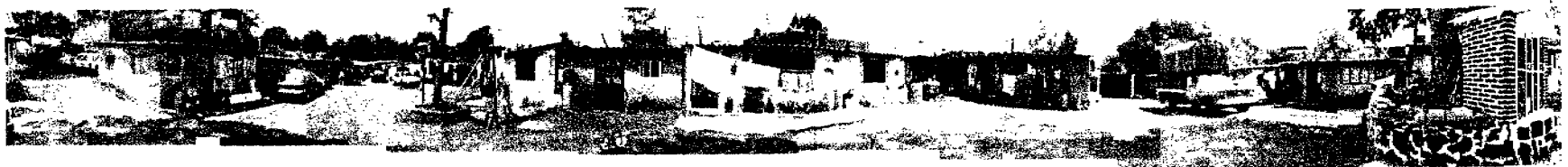
D. VISTA INTERIOR A.360°. Fachadas interiores actuales con acabado de pintura de cal sobre muros de tabique o block sin aplanados, la cancelería no tiene relación entre sí, por lo que la disposición con respecto al predio genera un patio central.
