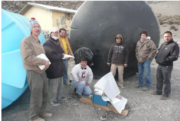
Fig.4.17. Pruebas para verificar la completa opacidad del tanque grande.
