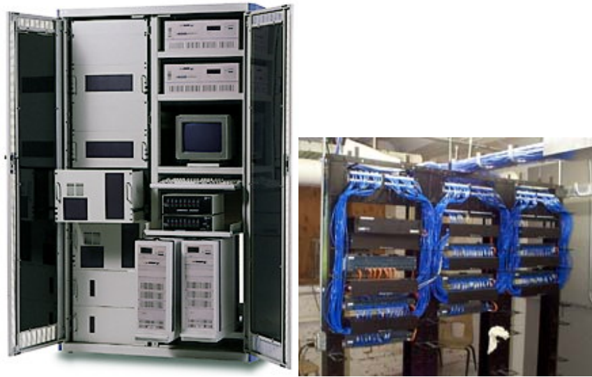
Racks o gabinetes de telecomunicaciones
