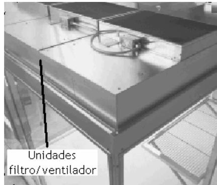
Figura 23. Unidades filtro / ventilador.<sup>(36)</sup>
