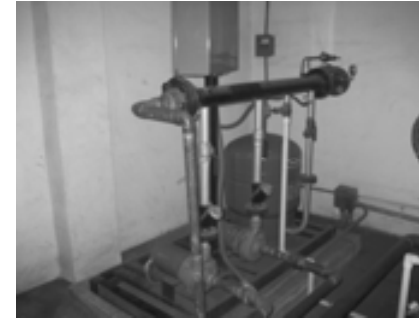
11- Sistemas de bombas e hidroneumáticos para la alimentación y suministro de agua.
