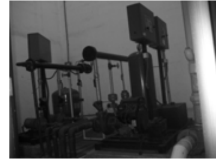
11- Sistemas de bombas e hidroneumáticos para la alimentación y suministro de agua.
