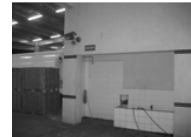
16- Pileta para lavado de equipos después de un siniestro.
