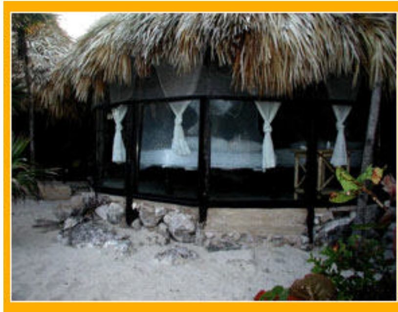
Foto 14. Cabaña vista desde el exterior.
