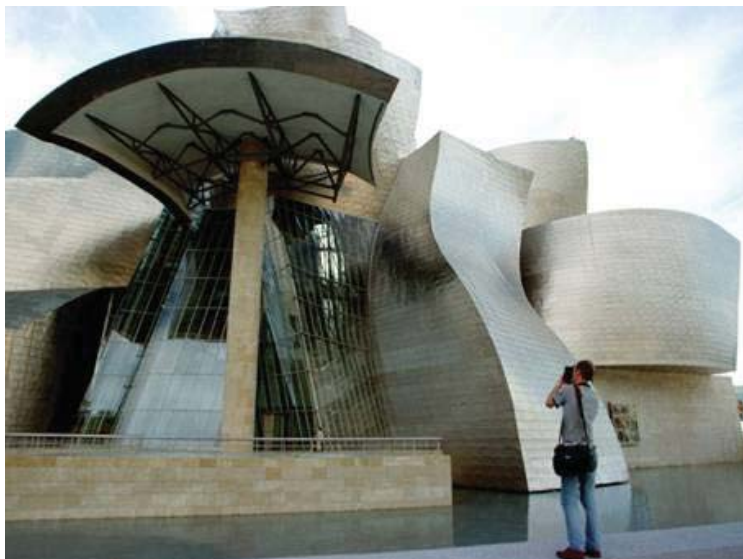
Guggenheim Bilbao. Vista de la cubierta.
