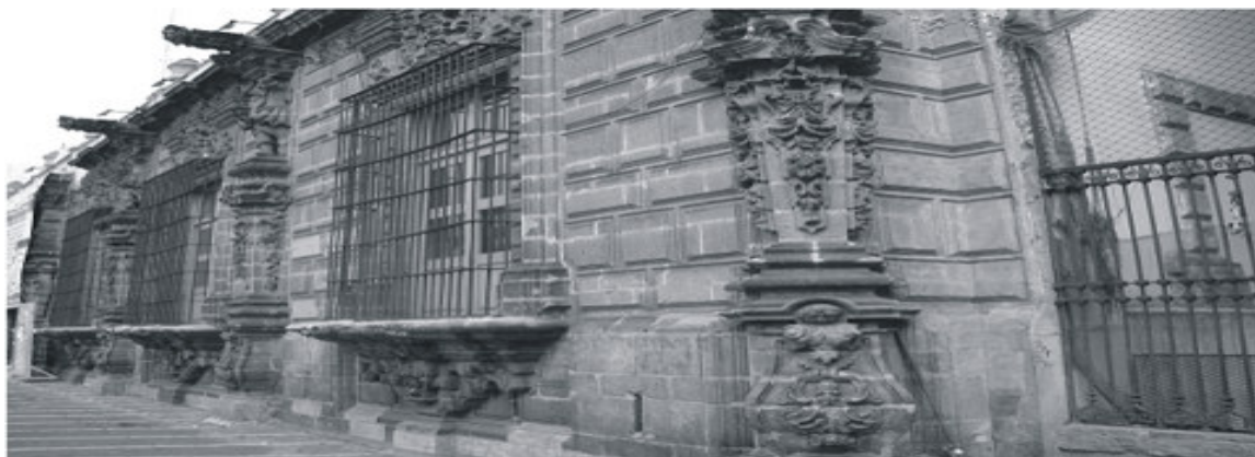
Vista de un costado de la Casa de los Mascarones.
