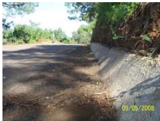
Fig. 3.7. En la foto de la izquierda se aprecia la erosión debido a la inadecuada salida del lavadero. En la foto derecha se observa que la cuneta no cuenta con la profundidad necesaria para drenar el agua adecuadamente.
