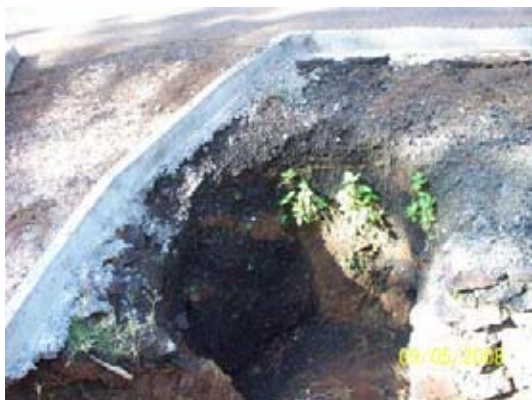
Fig. 3.7. En la foto de la izquierda se aprecia la erosión debido a la inadecuada salida del lavadero. En la foto derecha se observa que la cuneta no cuenta con la profundidad necesaria para drenar el agua adecuadamente.
