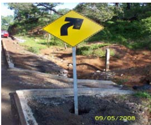
Fig. 3.7. En la foto de la izquierda se aprecia la erosión debido a la inadecuada salida del lavadero. En la foto derecha se observa que la cuneta no cuenta con la profundidad necesaria para drenar el agua adecuadamente.
