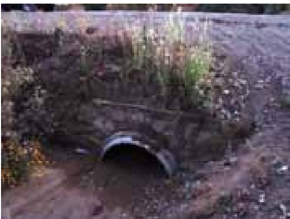
IMAGEN 21. Alcantarilla azolvada.
