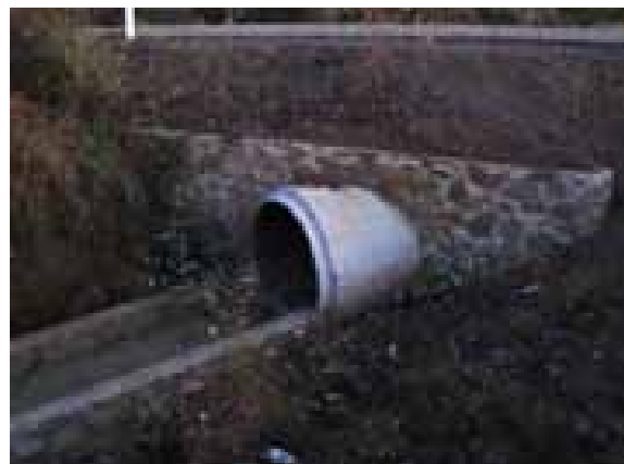
IMAGEN 22. Alcantarilla en buen estado.
