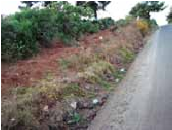
IMAGEN 25. Cunetas deterioradas.
