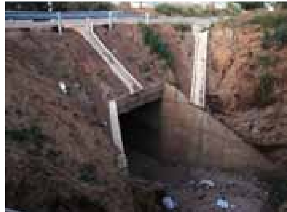
IMAGEN 24. Alcantarilla en buen estado.
