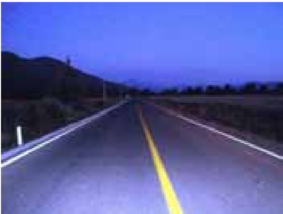
IMAGEN 19. Estado de la superficie de rodamiento.
