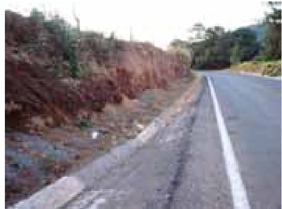
IMAGEN 26. Cunetas en buen estado.
