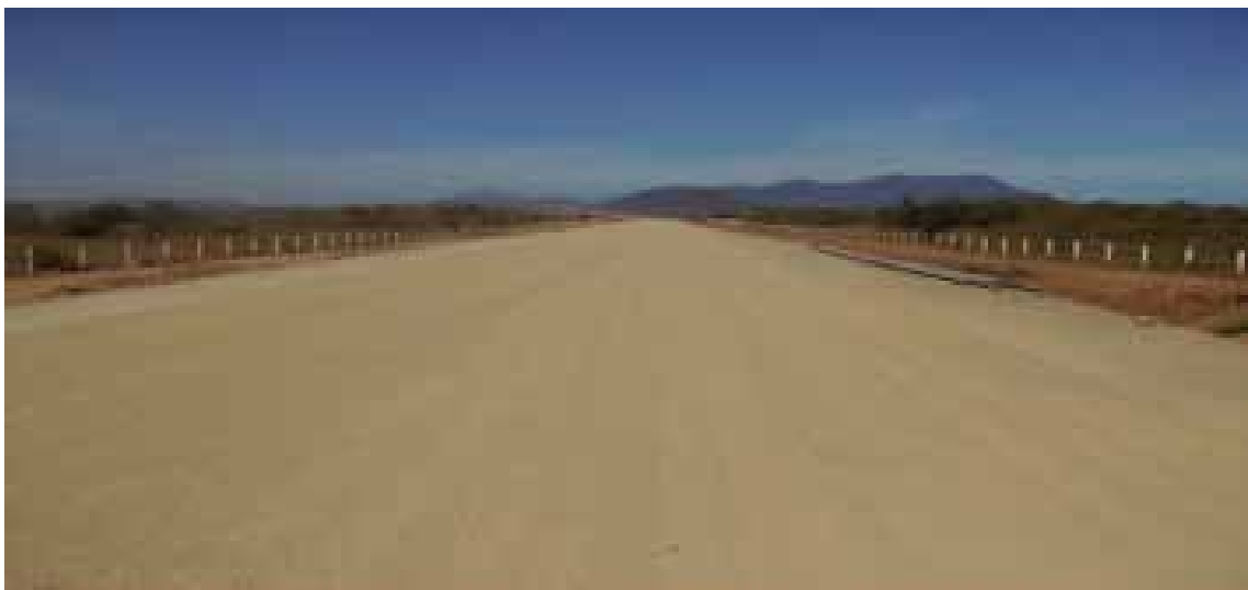
Fig. 3.7. Informe fotográfico de terminado de terracerías.
