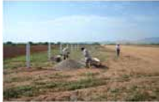
Fig. 5.16 Cercado del derecho de vía.
