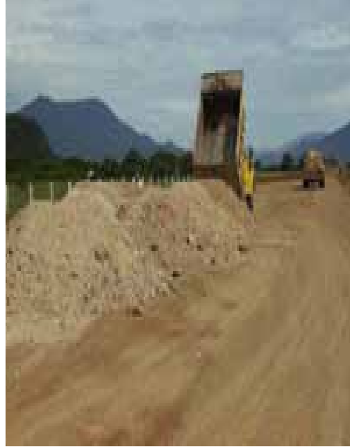
Fig. 5.13 Acarreo para terracerías.
