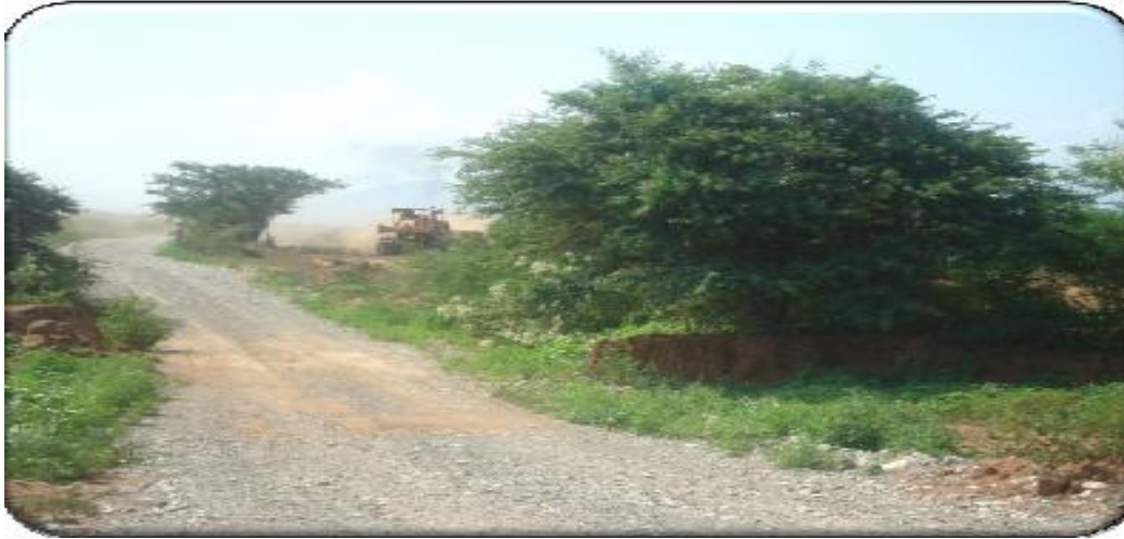
Fig. 3.6 Informe fotográfico del lugar.
