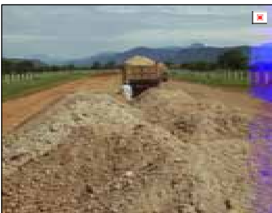
Fig. 5.8. Material para subyacente.
