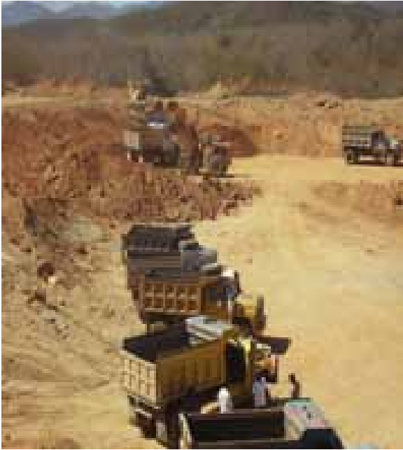
Fig. 5.12 Acarreo para terracerías.
