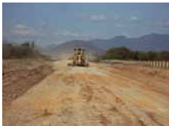
Fig. 5.11 Material para sub- balasto.
