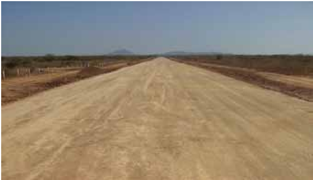
Fig. 3.9. Informe fotográfico de terminado de terracerías.
