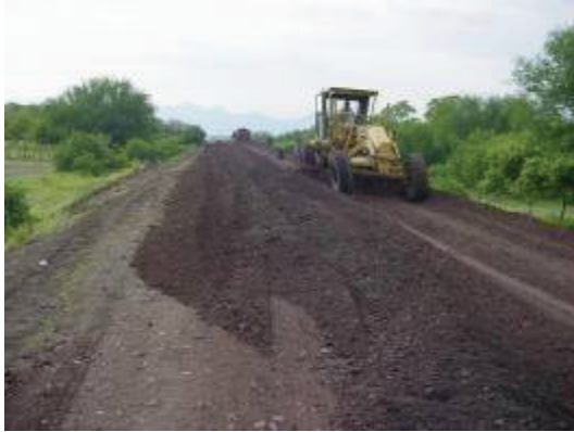
Foto no. 1.- tendido de material de base
