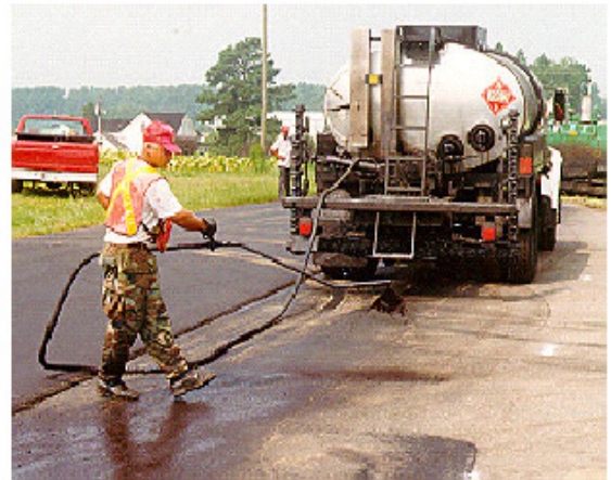
Foto 2 y 3.- Camiones con barra de distribución y con manguera de aplicación.
