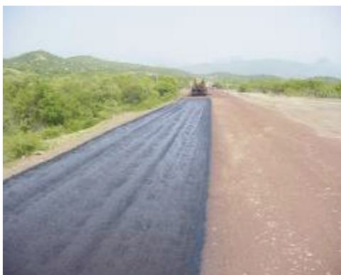
Fotos no. 4 y 5.- realización del riego por impregnación.
