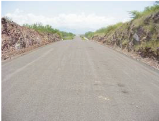
Foto no. 6.- tramo terminado después de la impregnación con poreo.
