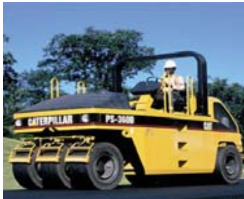
Foto 5.- Compactación con rodillo neumático.
