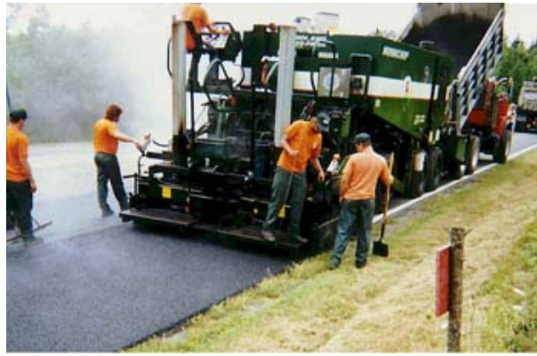
Foto 1.- Tendido de carpeta asfáltica en caliente.
