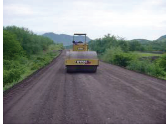
Foto no. 2.- Compactación de material para formar el cuerpo del camino.
