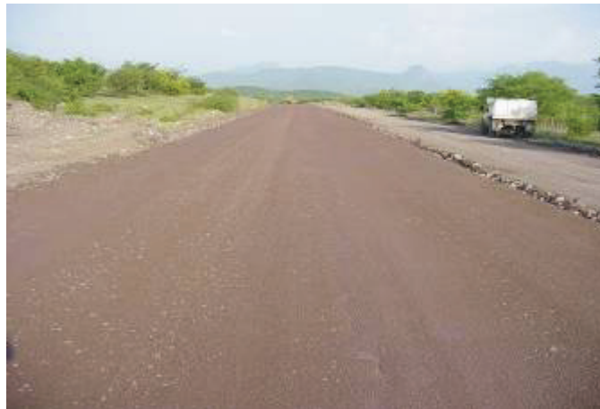
Foto no. 3.- se observa el camino terminado
