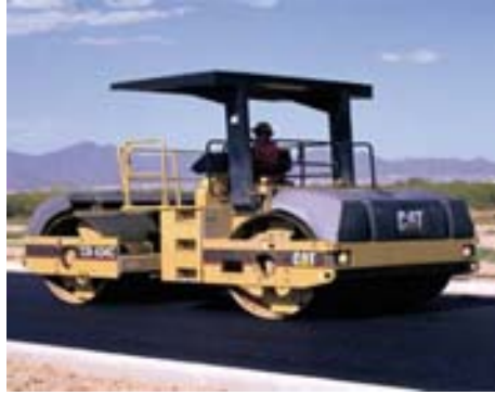
Foto 4.- Compactación con rodillo tándem.
