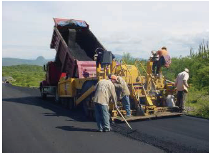
Foto no. 10.- afinando el tendido de concreto asfáltico.
