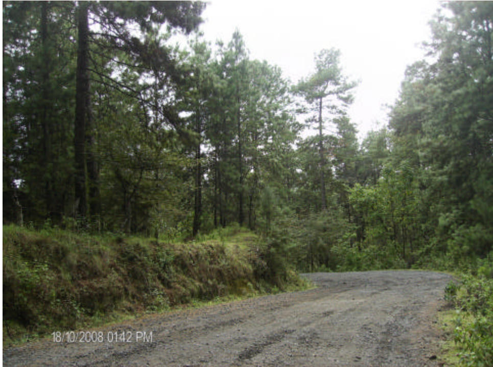
FOTO 3: Zona en la cual habrá corte para ampliación de curva según proyecto.
