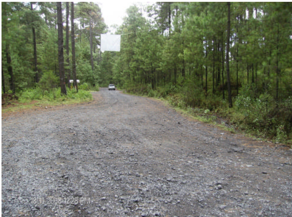
FOTO 4: Estación 11+000 vista hacia atrás
