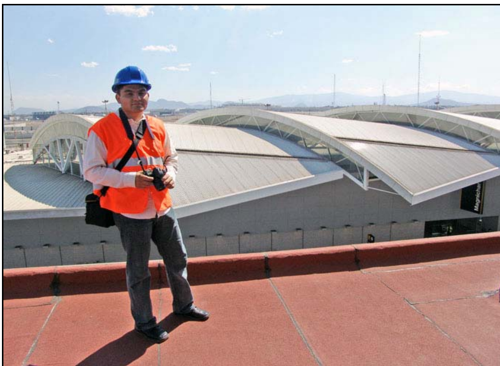
El autor en un recorrido fotográfico durante las obras de ampliación del AICM. (Foto: Armando González/Gerencia de Comunicación Social del AICM)
