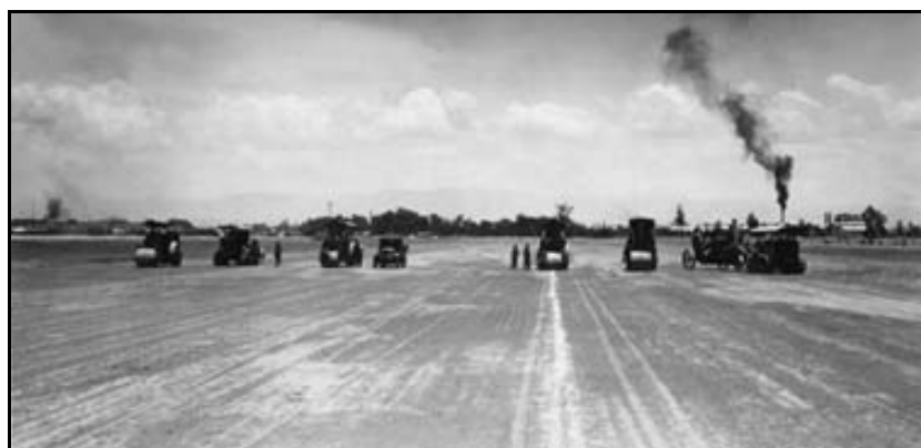
Trabajos de construcción de las pistas del Puerto Aéreo Central, a principios de 1928. (Foto: Archivo Histórico de Estrategia Aeronáutica. Revista América Vuela #83, en www.portalaviación.com )
