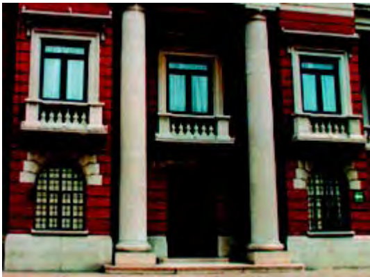
Imagen 159. Vista de una de las entradas de acceso al palacio municipal.
