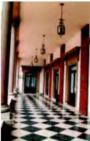
Imagen 111. Pasillo del palacio municipal de Tlalnepantla de Baz.
