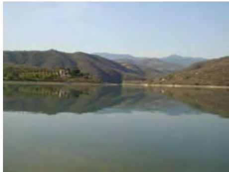
Figura 3.3. Presa de Jalpan
