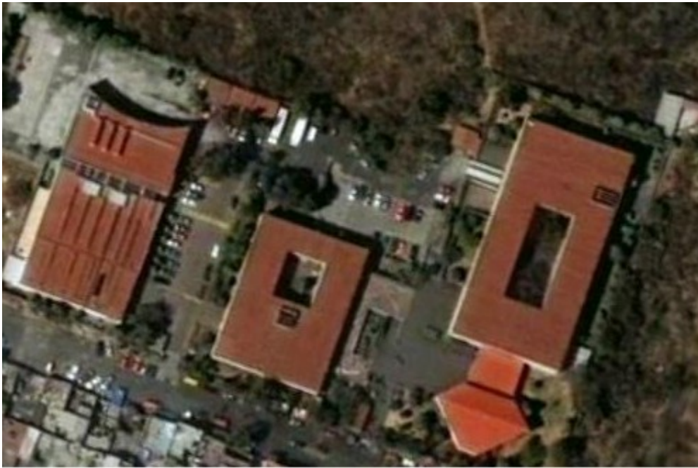
Figura 1. Vista panorámica de los 3 edificios de la ENAH 2
