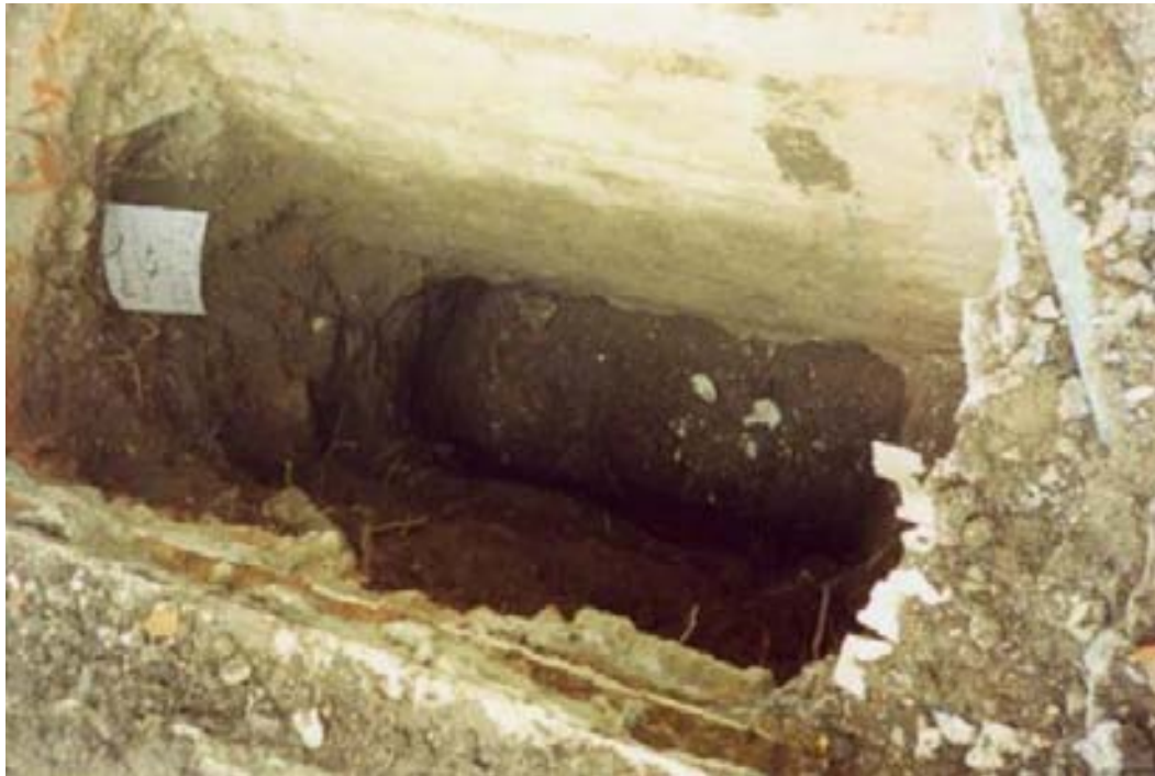
Fig. Pozo PCA – 1.
