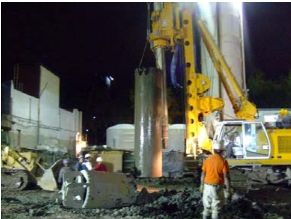
Fig. Excavación de pilas.
