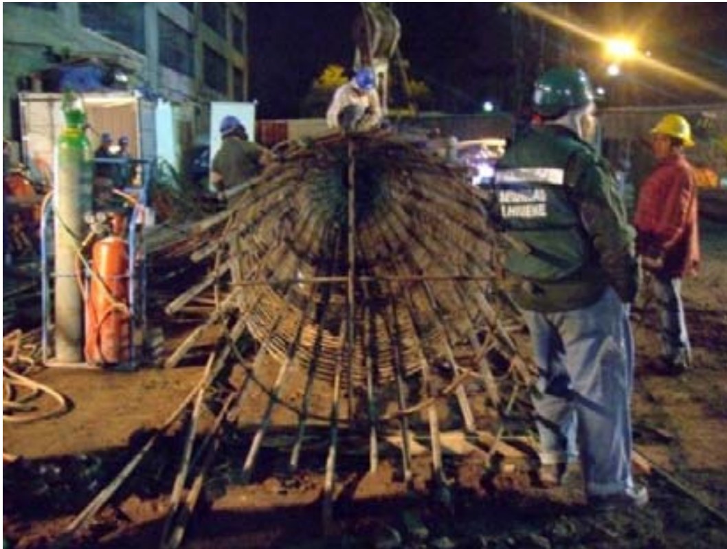
Fig. Armado de pilas.
