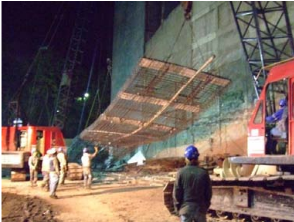
Fig. Colocación de armado de muro Milán.
