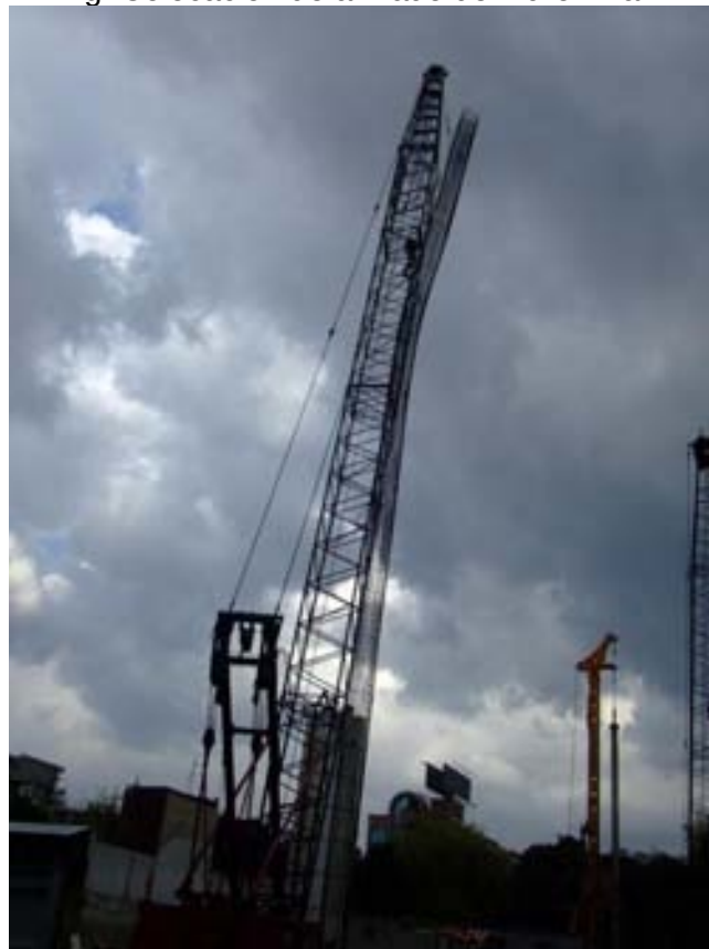
Fig. Colocación de armado de pilas.
