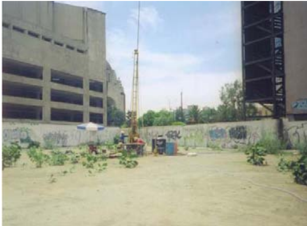
Fig. Ejecución del sondeo SE -1
