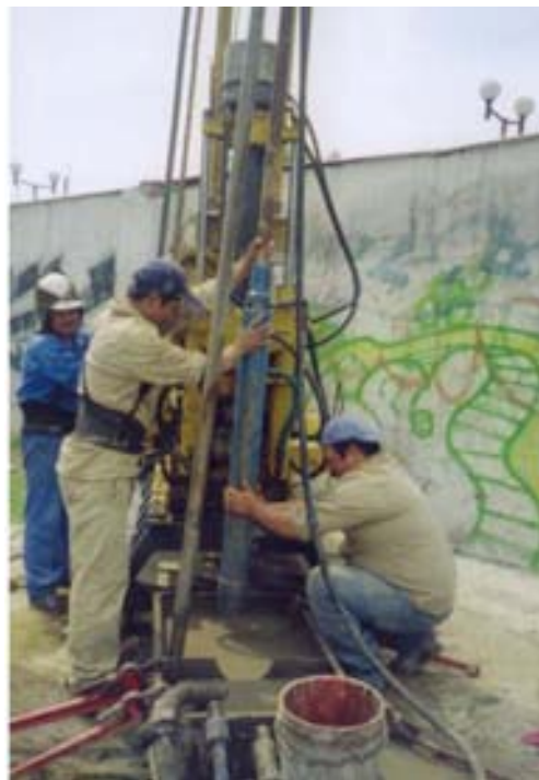
Fig. Aspectos de la realización del sondeo de muestreo inalterado.
