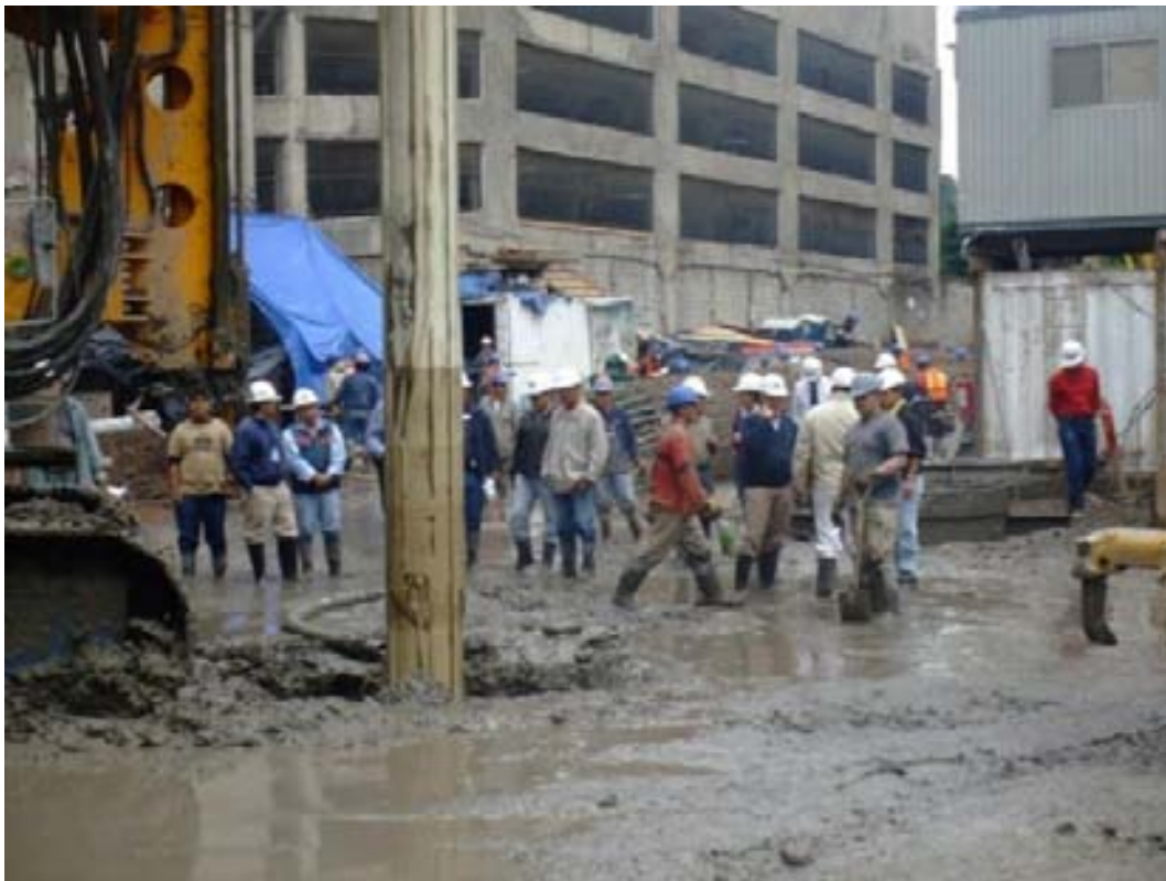
Fig. Colado de pilas.
