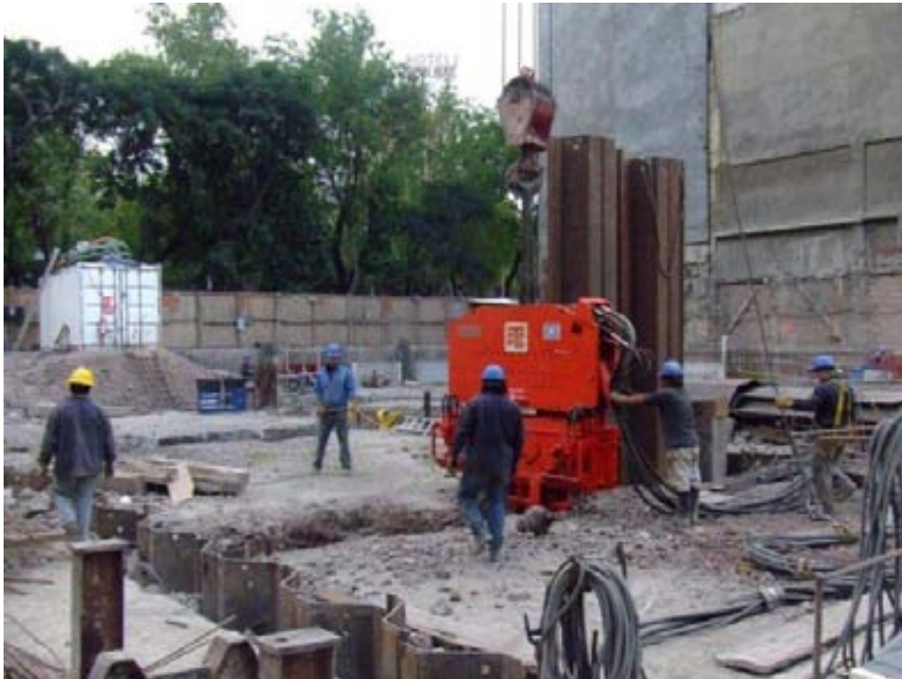
Fig. Instalación de tablestaca auxiliar.
