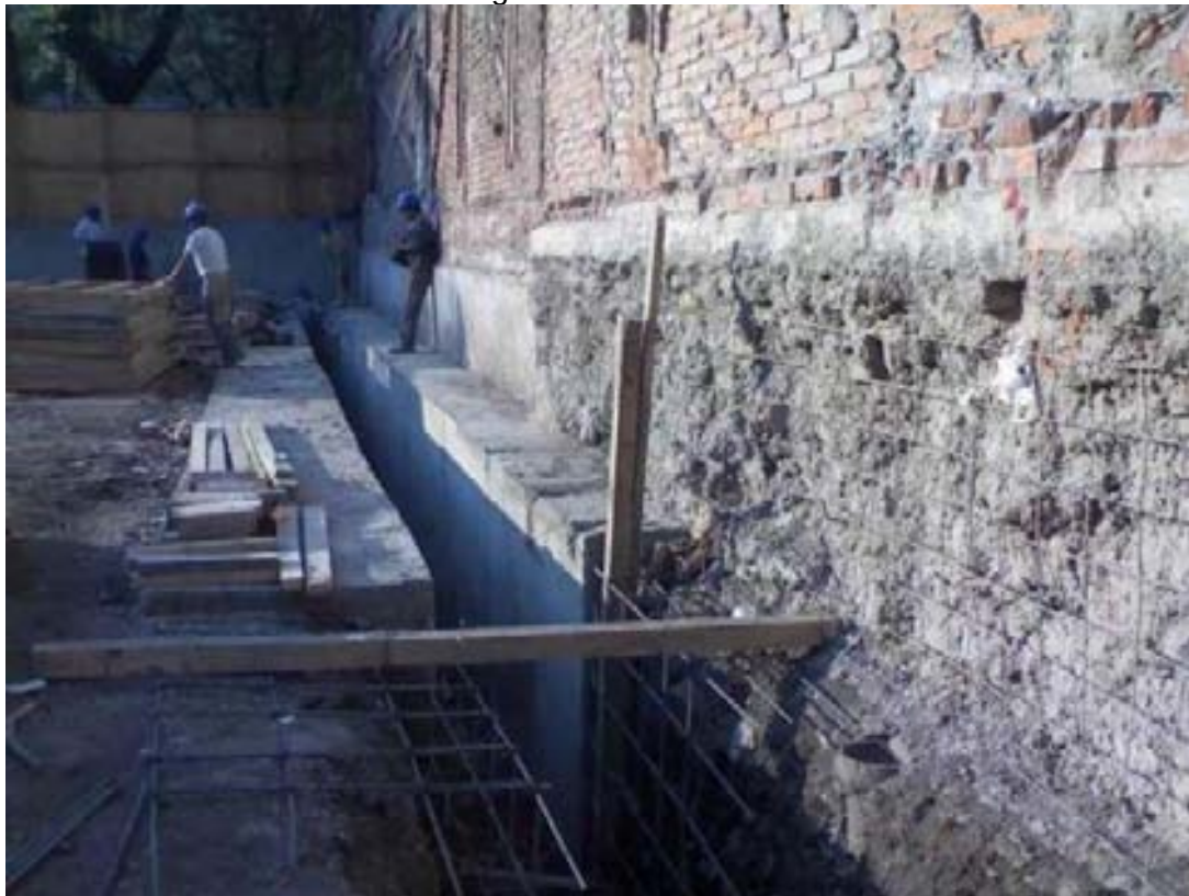
Fig. Construcción de brocal para muro Milán.
