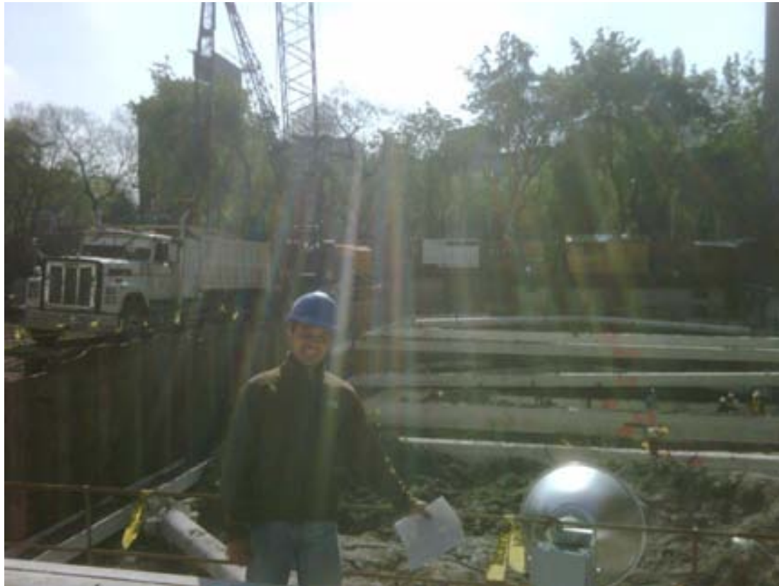
Fig. En el sitio de construcción
