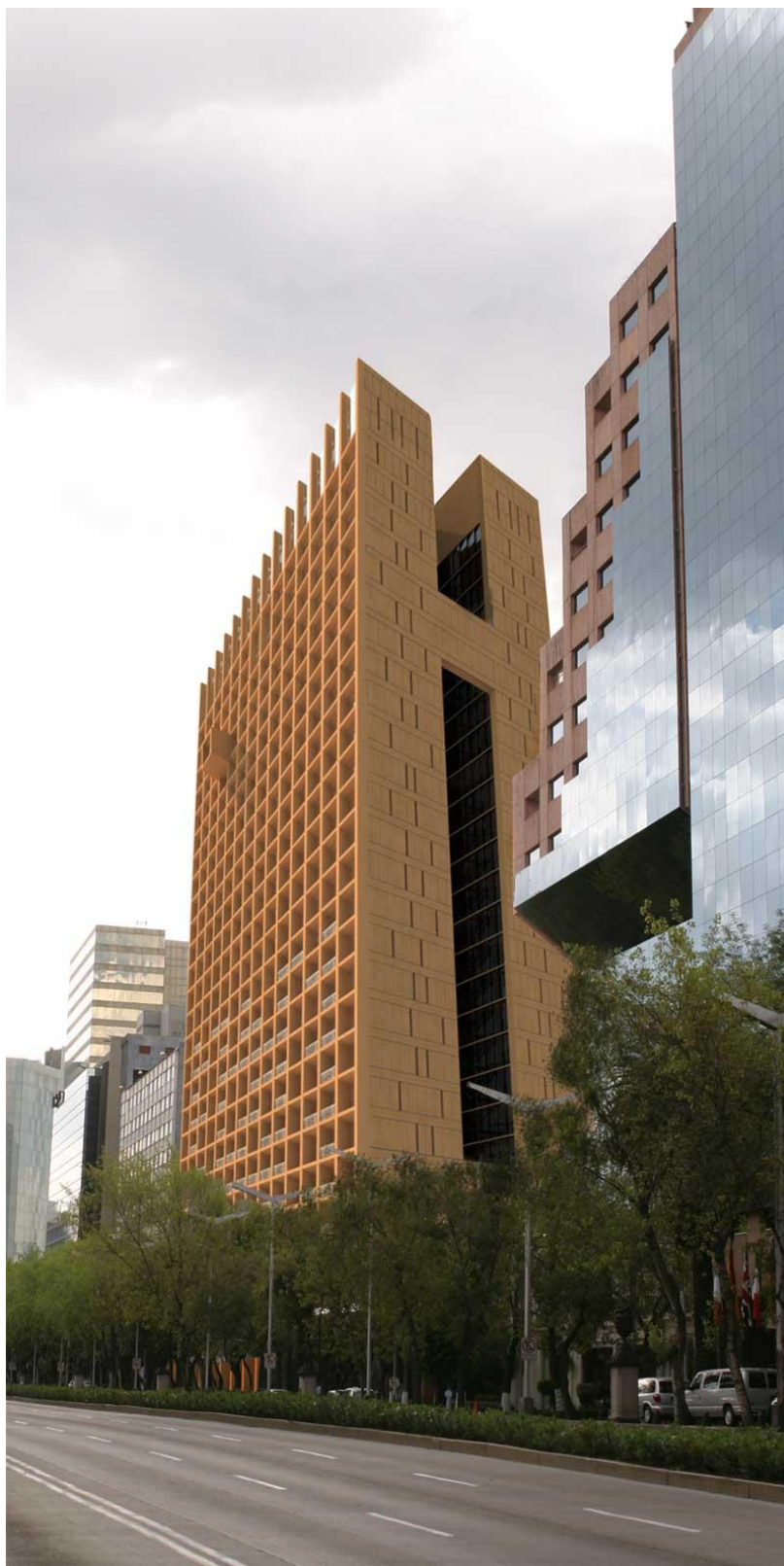
Fig. Fachada Reforma
