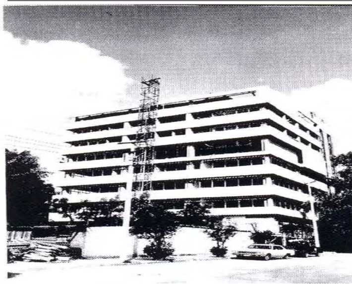
Imagen 5. El Centro Universitario Cultural, A. C., en construcción.
