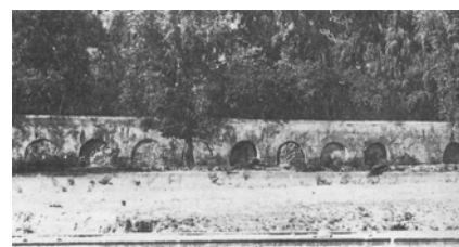
(60) Tramo de la arquería de Santa Fe entre la Hacienda de los Morales y el Molino del Rey
