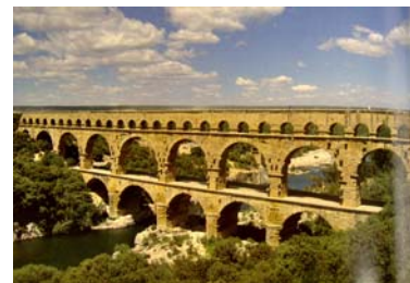
(26) Acueducto romano, obra patrocinada posiblemente por Agripa. El arco mayor tiene una luz de 24,50m la abertura total es de casi 50m y su longitud, de 275
