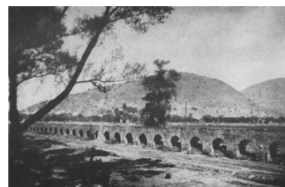
(67) Acueducto de la Villa de Guadalupe
