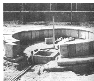
(83) Construcción de las fuentes, en la plaza de Santa Catarina M.
