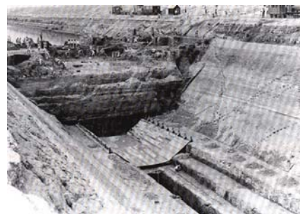
(176) Obras de construcción del "Gran Canal" del Desagüe de la ciudad de México 1905.
