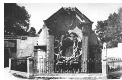
(68) Caja de Agua en la Villa de Guadalupe.
