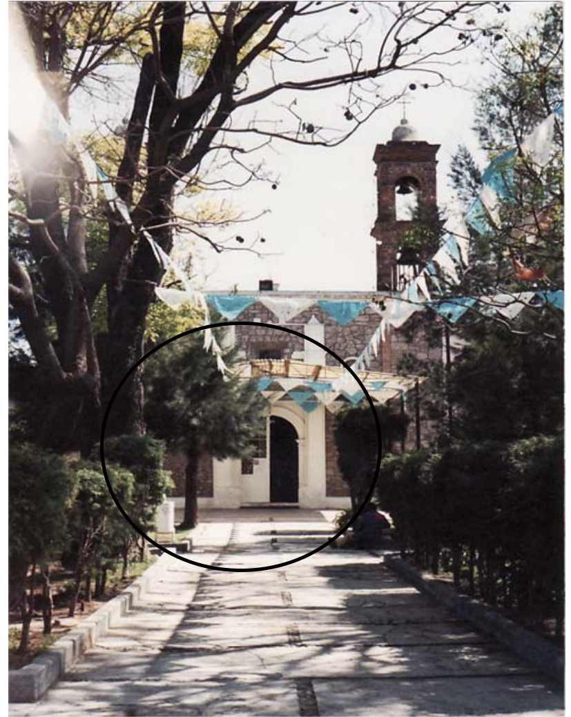
Vista frontal de la Parroquia con la techumbre metálica.
