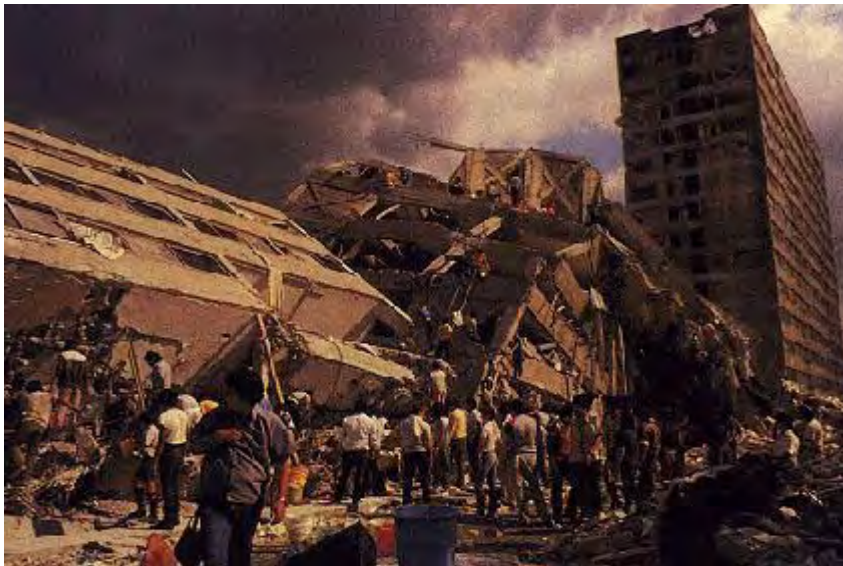
Figura 1.4 Edificio Nuevo León, México 1985 (Cárdenas, 1998)
