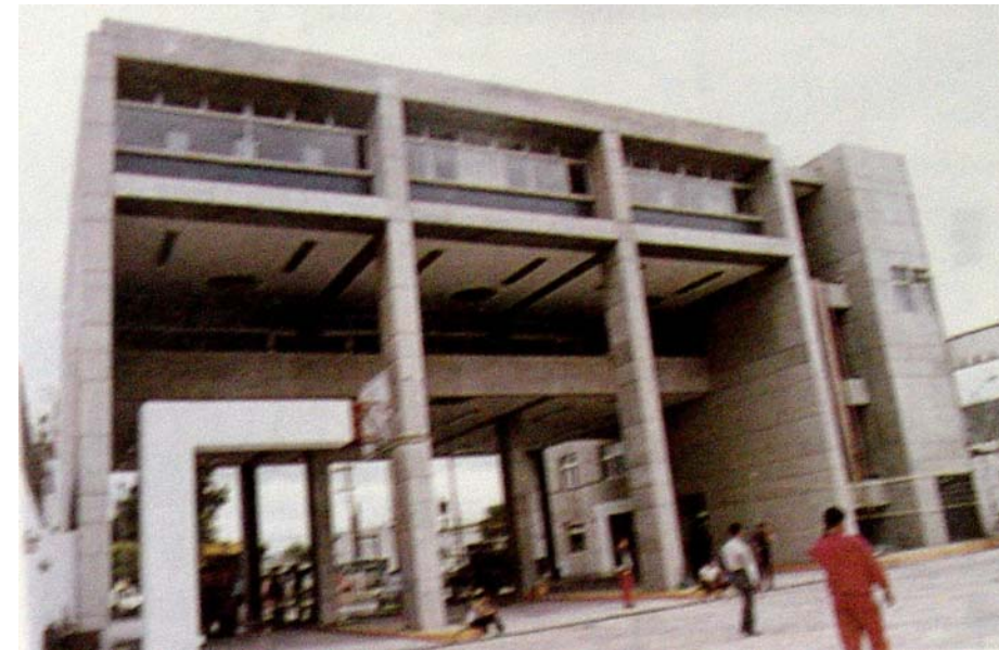
VISTA DEL EDIFICIO DESDE EL PATIO DE MANIOBRAS
