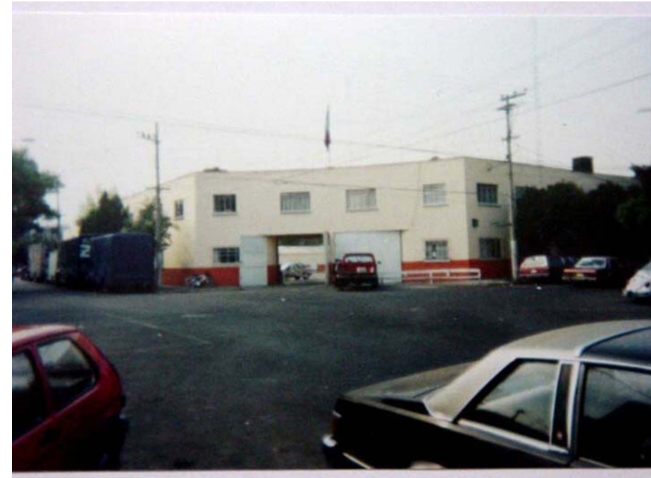
FOTO 3 IMAGEN DESDE EL SURESTE DEL TERRENO SE MUESTRA LA EXPLANADA VIAL GENERADA POR EL RECORTE DE LAS ESQUINAS CONVERGENTES EN EL CRUCE DE LAS CALLES MONROVIA Y NECAXA, GENERANDO LA QUINTA FACHADA DEL PREDIO MISMA QUE SE APRECIA EN EL PLANO DE FONDO DE LA IMAGEN. ASIMISMO SE MUESTRAN VEGETACIÓN Y POSTES DE ENERGÍA ELÉCTRICA.
