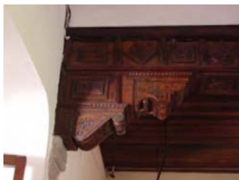
104. Detalle de can que da apoyo a una viga (interior del convento).
