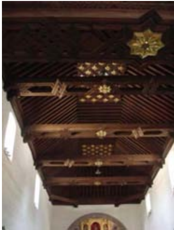
98. Vista general de la techumbre de la Catedral de Tlaxcala
