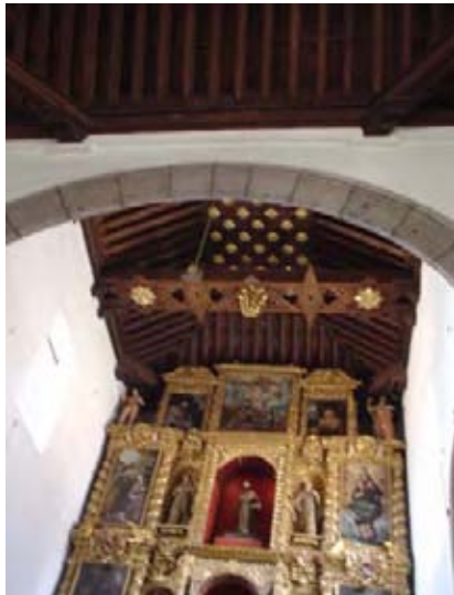
100. Vista de la armadura del presbiterio, Catedral de Tlaxcala
