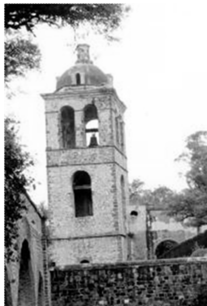
110. Torre del convento de N.S.A.. Tlaxcala
