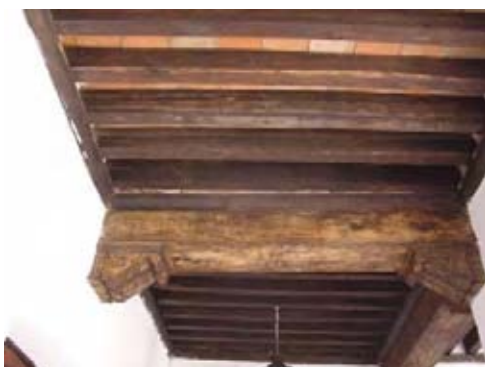
103. Vista de alfarje en el interior del convento.
