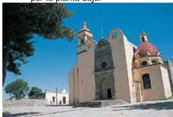
126. Fachada principal, San Ildefonso, Hueyotlipán, Tlaxcala
