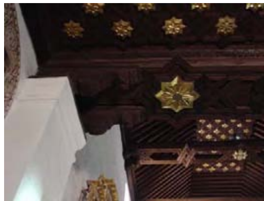
97. Detalle canes y tirantes en el coro, la Asunción, Tlaxcala
