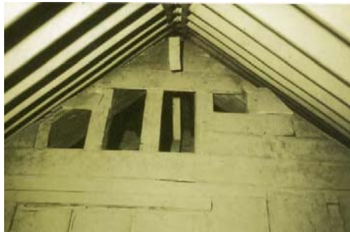
101. Cubierta metálica del presbiterio, vista del faldón oeste
