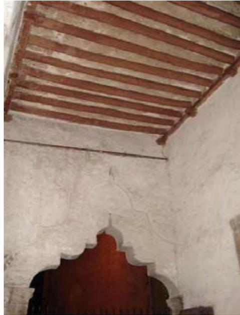
Al lado de la sacristía se localiza un portal formada por tres arcos mixtilíneos en su fachada principal y otro en la fachada lateral. Tiene una cubierta horizontal formada con rollizos de madera.
