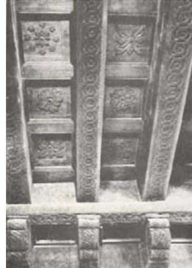
En los otros casos estudiados, las vigas apean directamente sobre los canes y éstos van únicamente paralelos a las vigas, pero en este caso las vigas apean sobre estribos y los canes perpendiculares a las vigas únicamente sostienen el estribo.
