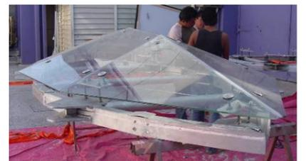
Fig. 4.14 Instalación de cristales a linternilla superior
