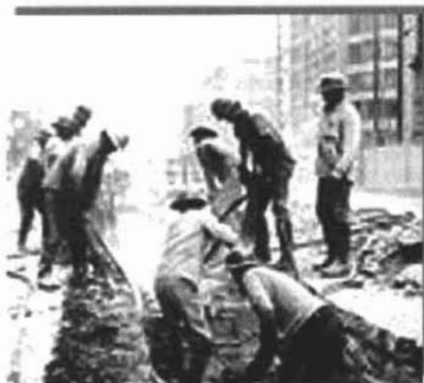
Fig. 1.15. Obras de la construcción del metro capitalino.
