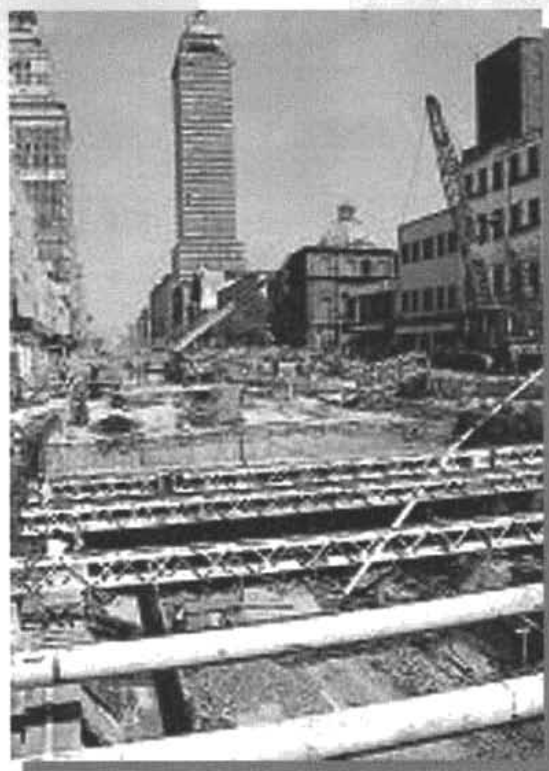
Fig. 1.16. Detalle de la construcción de la Línea 1 del Metro.
