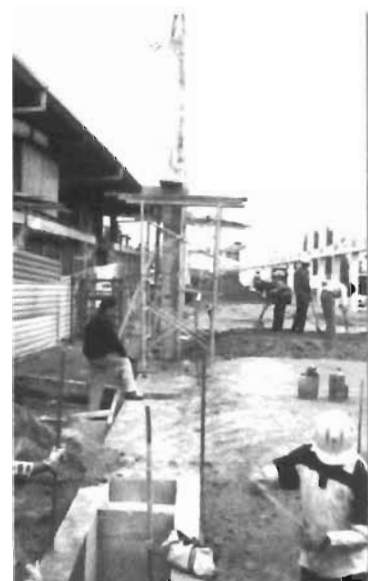
Fig. 2.1. Construcción de la línea B del metro.
