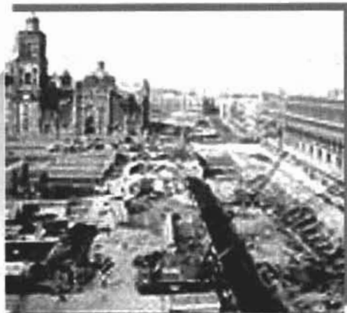
Fig. 1.14. Construcción del metro de la ciudad de México en 1968.
