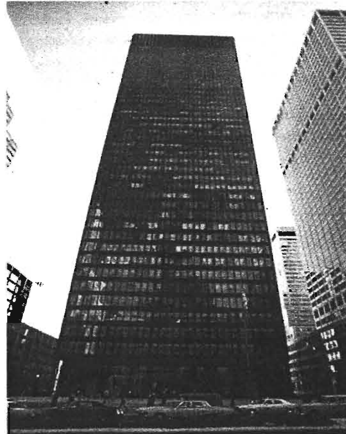
Edificio Seagram. Nueva York (1954-58) Mies van der Rohe & Philip Johnson
