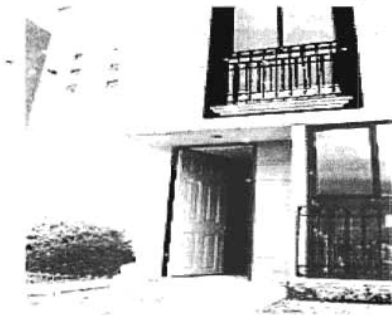
Figura 20. Construcción de habitaciones con bloques de cerámica
