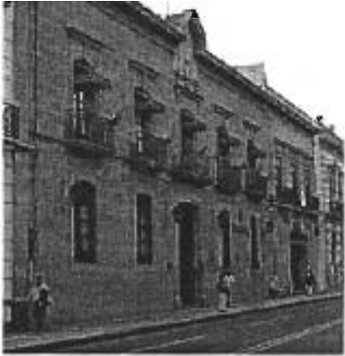
Antigua casa del Diezmo, hoy BANAMEX, Michoacán. La restauración del monumento arquitectónico responde a un uso necesario para la vida cotidiana, resultando un elemento emblemático de refuerzo positivo a la promoción del servicio que se presta.
