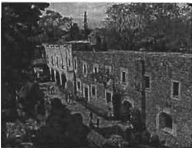
El pasillo de servicio es lo que actualmente se conoce como el acceso al MNI y demás dependencias a cargo del INAH.
