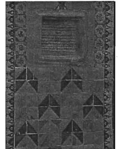
Detalle de los azulejos sustituidos en la Capilla de San Antonio en 1939.
