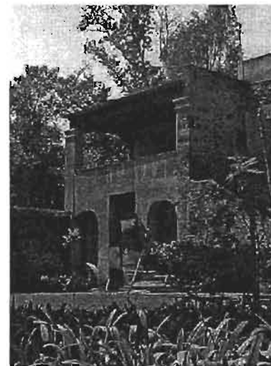
Las necesidades de espacio de la CNMH no solo requirió la construcción de agregados provisionales si no además confirió nuevos usos al monumento histórico.
