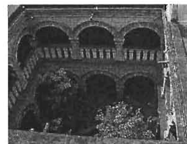
Vista superior de la arcada de los claustros que presenta pintura mural decorativa.
