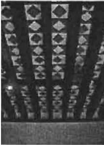
13b Reposición de enladrillado entre la vigería de los techos según procedimiento techos 1,2
