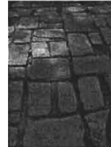
13c Reposición de piezas de cantera en pisos según procedimiento pisos 4.
