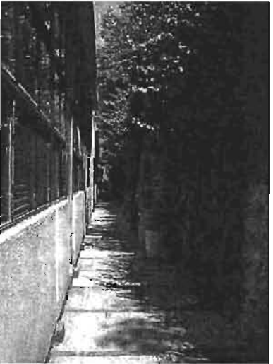
Agregados provisionales en la huerta del ex convento de Churubusco para albergar la ENCRyM, se observa que el criterio de reversibilidad consiste en aislar la nueva construcción de la barda perimetral.
