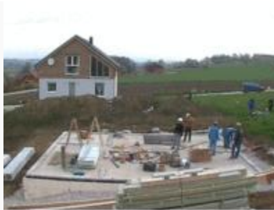
Construcción de una casa prefabricada modular.
