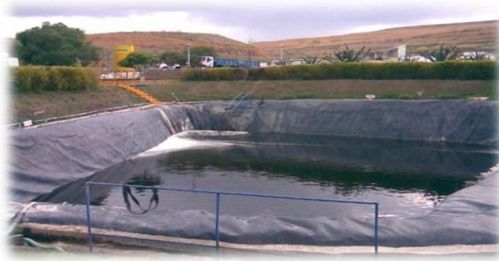
Foto 3.1 Laguna de almacenamiento del lixiviado del relleno sanitario de Tlalnepantla
