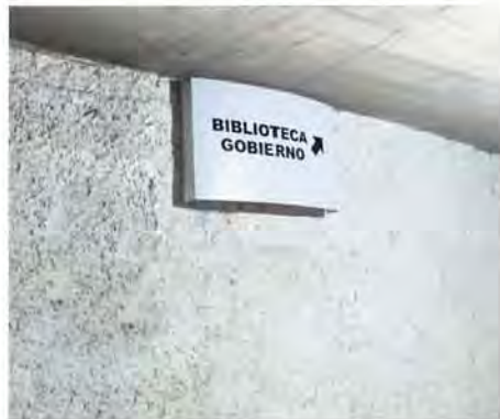
Imagen de la mampara a 3m de altura en una inclinación visual de 45° a una distancia de 2m.
