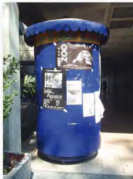
Imagen 11. Ejemplo de módulo de la FES Acatlán donde se aprecia el desgaste y desorden visual provocado por el uso de elementos de sujeción adhesivos para colocar los carteles.
