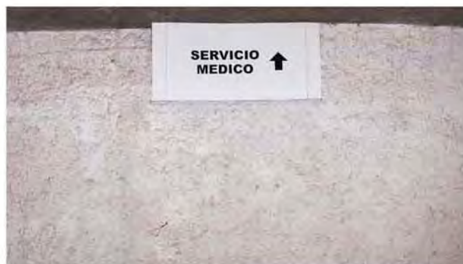
Imagen de la mampara a 3m de altura de frente a una distancia de 2m.
