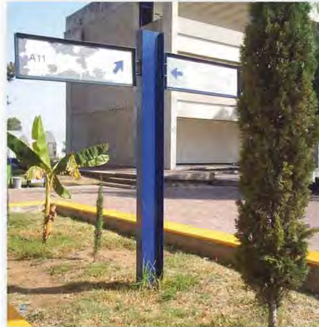
Imagen1. Ejemplo de señalización exterior de la FES Aragón donde se aprecia la carencia de información debido al deterioro de los materiales expuestos a la intemperie.
