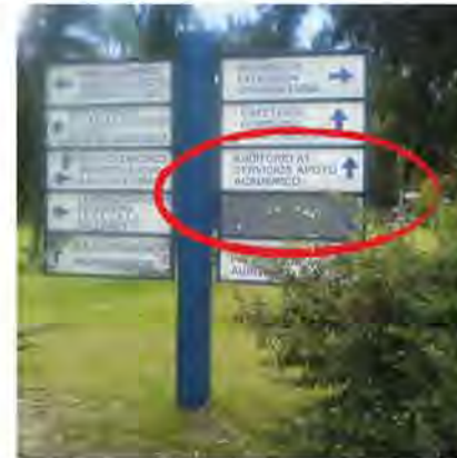
Imagen 29. Señalización de la FES Aragón. Puede apreciarse el desgaste de la superficie debido al deterioro físico y químico, lo que genera la caída del material.
