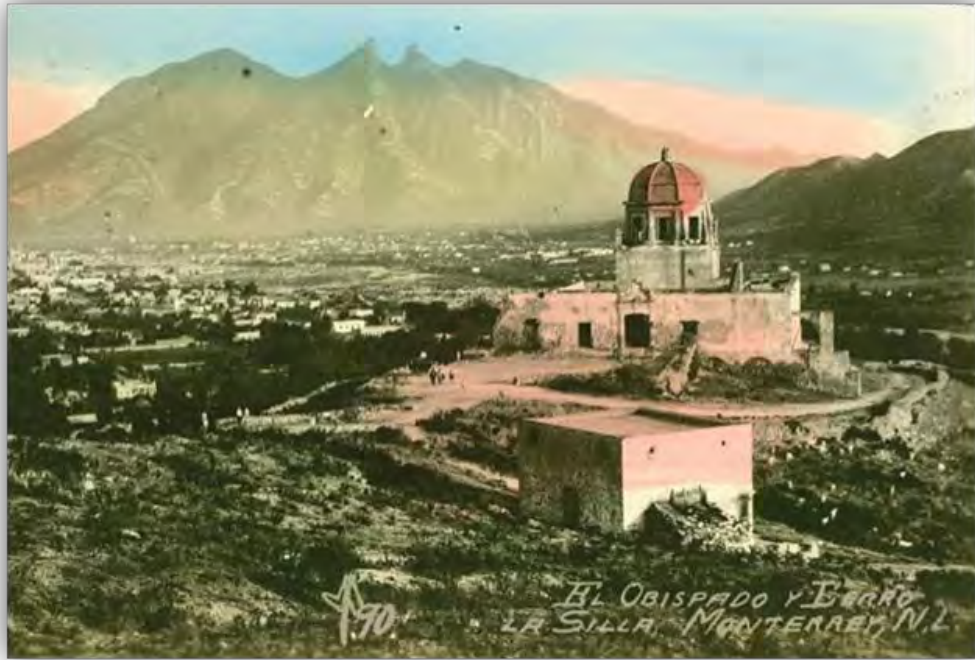
Fig. 58 Vista del Obispado y Cerro de la Silla, Monterrey, Nuevo León. Col. Fernando Elizondo
