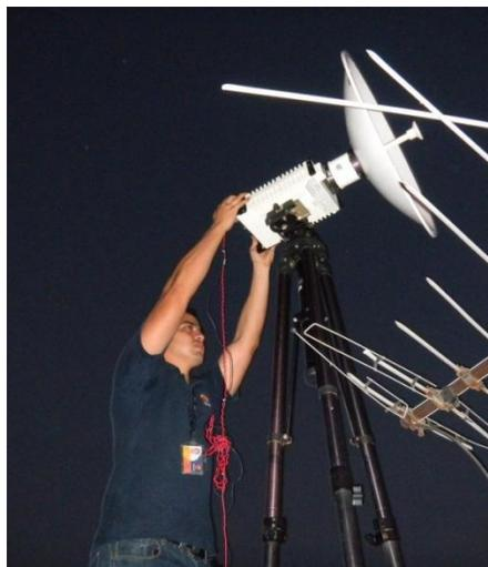
Fig. 3.10 Ajustes finales antena Tx.
