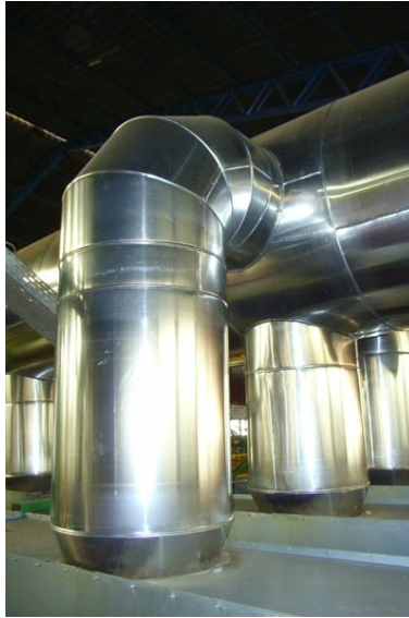
Figura 4.17 Recubrimiento de aluminio utilizado en la industria para equipos de refrigeración
