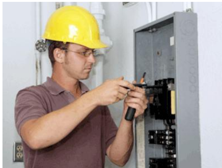
FIGURA 2.3. MANTENIMIENTO PREVENTIVO EN TABLEROS ELECTRICOS
