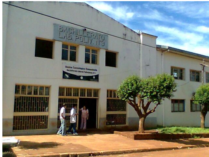
FIGURA 1.7. INSTALACIONES EN ÓPTIMAS CONDICIONES
