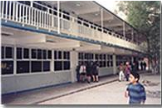
FIGURA 1.1. INSTALACIONES EN CONDICIONES ÓPTIMAS
