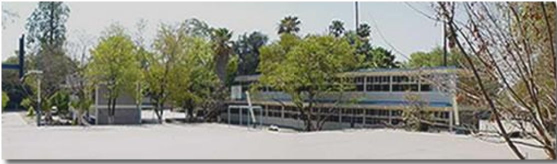
FIGURA 1.2. EDIFICIOS EDUCATIVOS Y EXPLANADA PRINCIPAL EN BUENAS CONDICIONES OPERATIVAS
