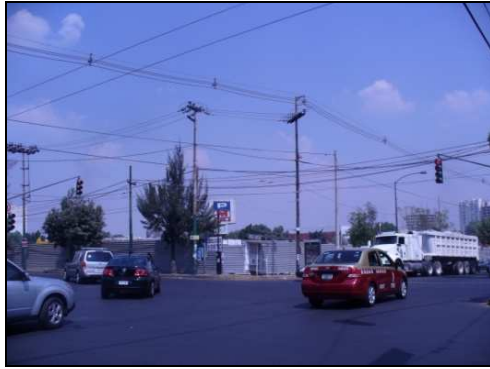
Fotografía No. 10: Vista del terreno desde la esquina Lago Alberto.
