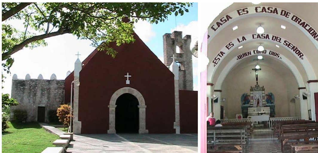
La capilla de San Miguel Arcángel por fuera y en el interior. Primer contacto en junio/2009
