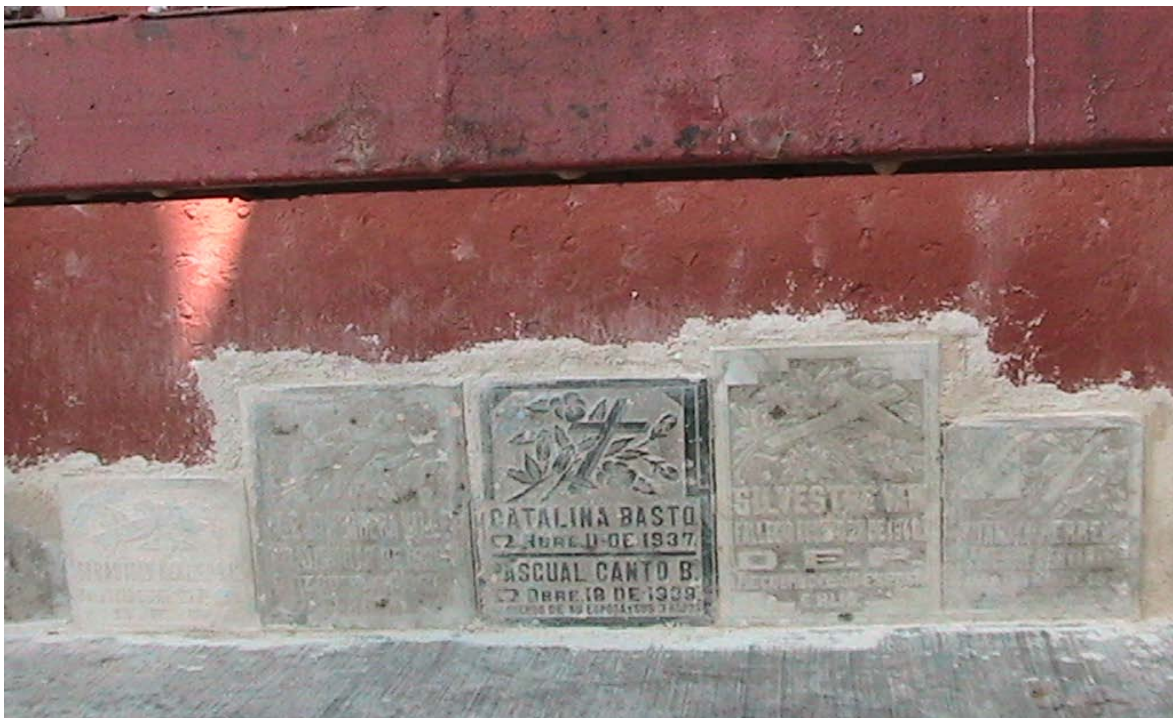
Parte de las lápidas extraídas de las paredes laterales y del piso del altar mayor. Fueron colocadas en el exterior de algunas de las paredes del templo, durante el año 2010
